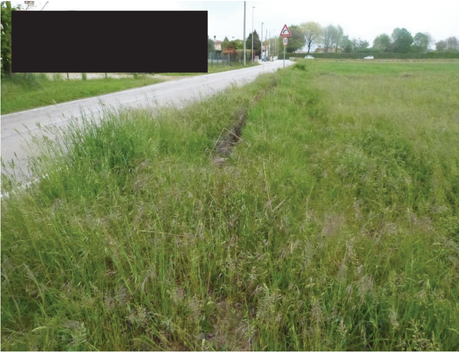
1 Limite del terreno lungo Via Monsignor Farina con canaletta irrigua a lato della strada.
